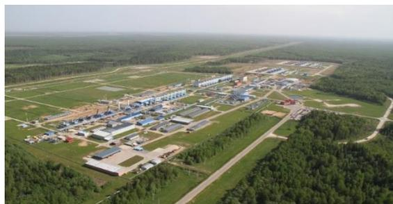
На сегодняшний день Нюксенское ЛПУ МГ – филиал ООО «ГазпромТрансгаз Ухта» - это газотранспортный комплекс из 7 цехов, перекачивающих природный газ 39-ю турбоагрегатами, электростанция собственных нужд, сеть действующих магистральных газопроводов общей протяженностью в однопоточном исполнении 1765 км.
