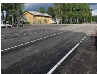
Ремонт асфальтобетонного покрытия ул. Советская, ул. Рубцова - 36 488 972,45 рублей
