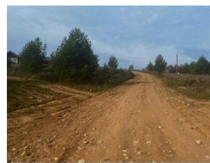
Отсыпка участка дороги к д. Семеново Гора - 180 000,00 рублей
