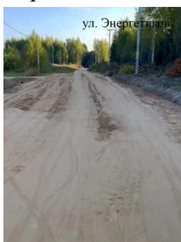
Ремонт участка дороги ул. Энергетиков - 543 214,4 рублей
