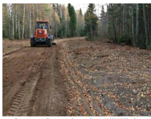
Ремонт дороги в Красвино-д. Озерки-и. Озерки -10 221 149,52 рублей
